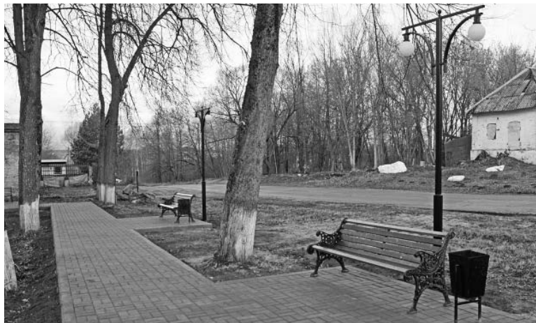
Первый этап строительства парка в Брыни завершен. Местная администрация принимает предложения от жителей по дальнейшему его обустройству и названию.
